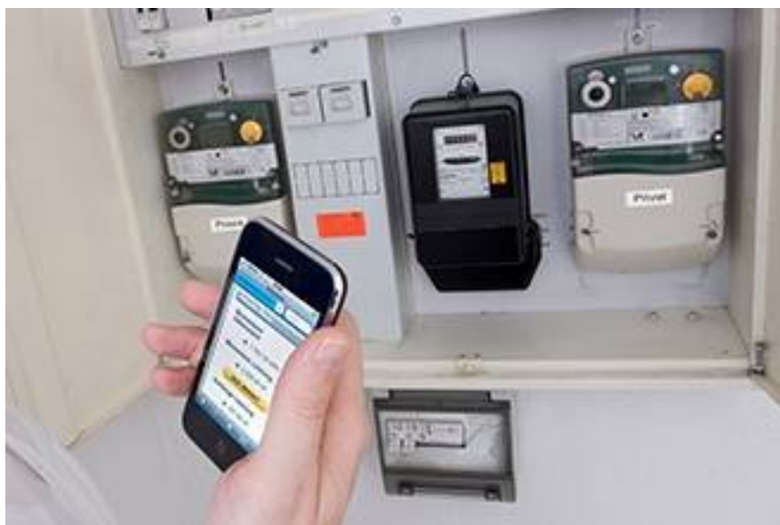
Рис. 6. Вариант размещения «умного» счетчика в квартирном электрощите
