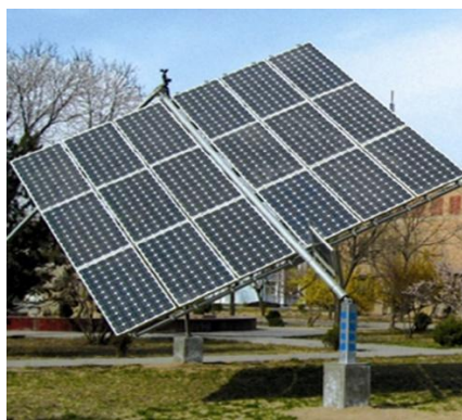
Рисунок 8 – СЭУ компании Traxle Solar, Чехия с трекером в полярных координатах
